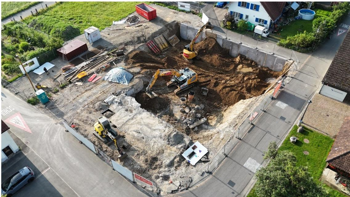
Noch während den Abbrucharbeiten wurde das Gelände zu den Strassen mit Grubenwänden gesichert.
