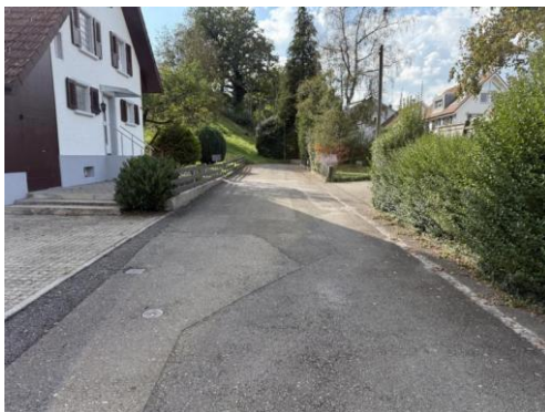
Abbildung 9 Ringweg West (Quelle: Bodmer Bauingenieure AG)
