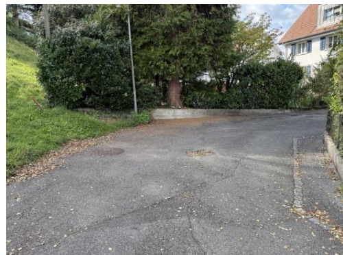
Abbildung 10 Ringweg West (Quelle: Bodmer Bauingenieure AG)
