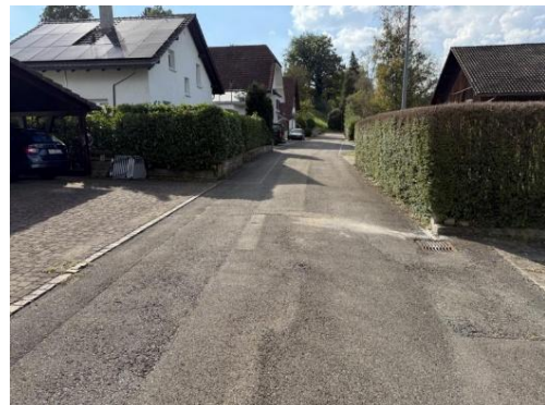
Abbildung 8 Ringweg West (Quelle: Bodmer Bauingenieure AG)
