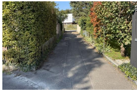
Abbildung 6 Fussweg (Quelle: Bodmer Bauingenieure AG)
