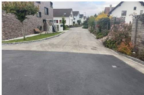
Abbildung 4 Im Winkel West-Ost (Quelle: Bodmer Bauingenieure AG)
