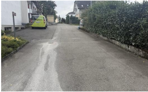
Abbildung 1 Im Winkel, Nord-Süd (Quelle: Bodmer Bauingenieure AG)
