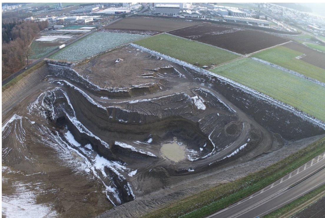
Abbildung 1-1: Orthofoto Materialabbaugebiet Oberbann (Porta AG, Befliegung vom 19.12.2022)
