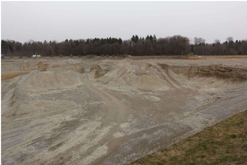
Foto 4: Abbaustelle Oberbann, 16.3.2022, Blick gegen Osten mit Zwischendepots
