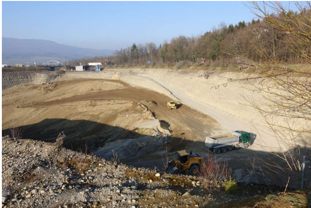
Foto 5: Abbaustelle Oberbann, 14.2.2023, Blick gegen Norden entlang östlicher Böschung, mit Auffüllung
