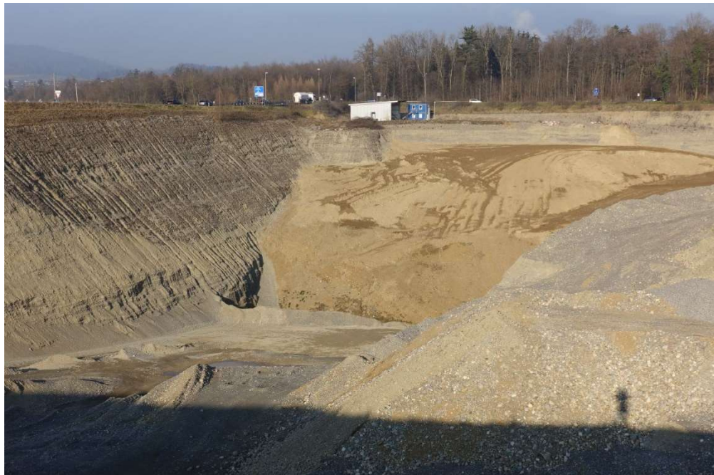
Foto 6: Abbaustelle Oberbann, 14.2.2023, Blick gegen Norden mit nordwestlicher Böschung und Auffüllung
