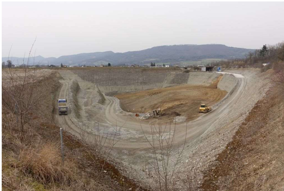
Foto 1: Abbaustelle Oberbann, 16.3.2022, Blick Richtung Norden entlang östlicher Böschung
