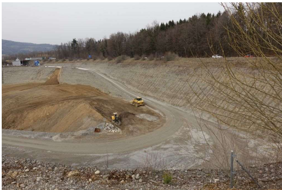
Foto 2: Abbaustelle Oberbann, 16.3.2022, Blick Richtung Nordosten gegen östliche Böschung
