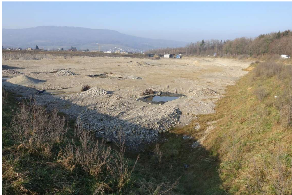
Foto 7: Abbaustelle Oberbann, 14.2.2023, Blick gegen Norden, vorbereitete neue Abbaufäche
