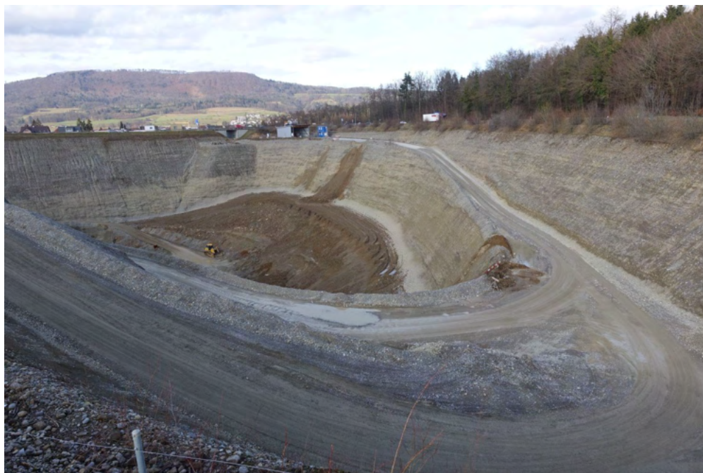
Foto 1: Abbaustelle Oberbann, Blick Richtung N entlang östlicher Böschung
